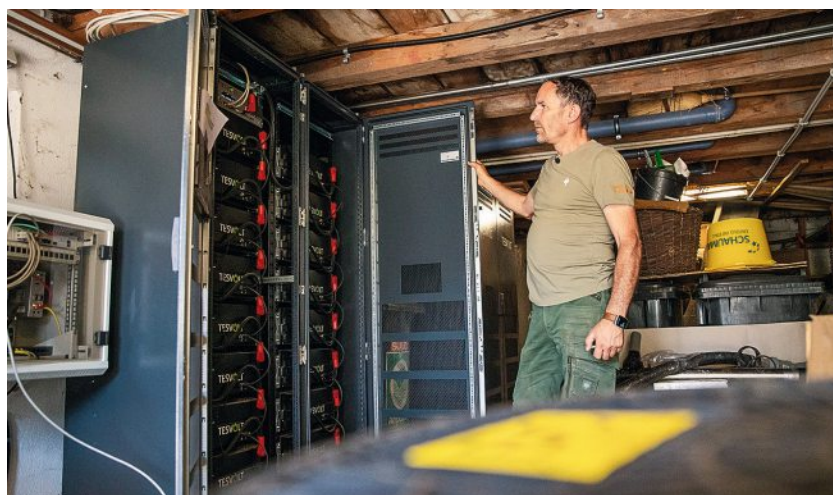
▽ 200 kWh Strom können in Batterien auf dem Hof gespeichert werden.
